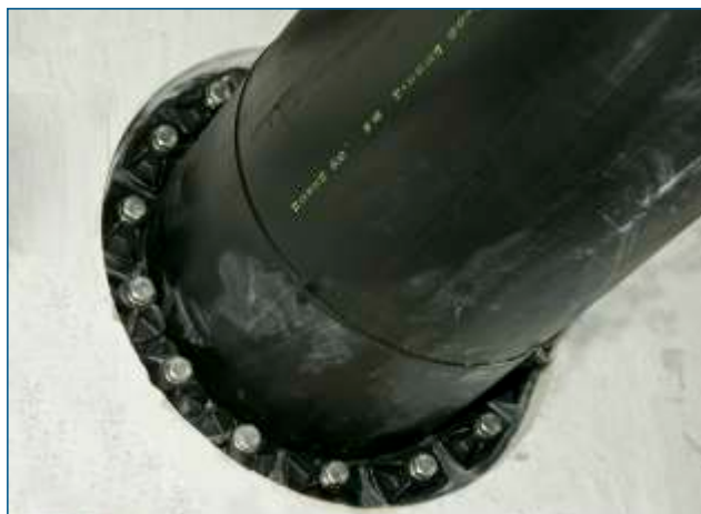
Rurociąg tłoczny fi 250.
