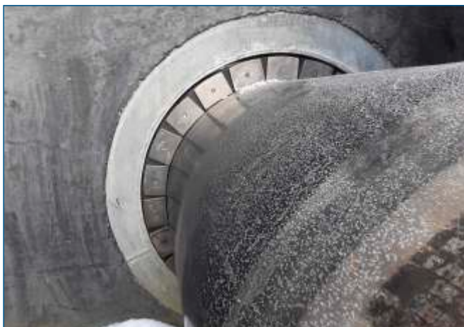
Kolektor ściekowy fi 600.
