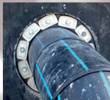
Rurociąg tłoczny fi 315.
